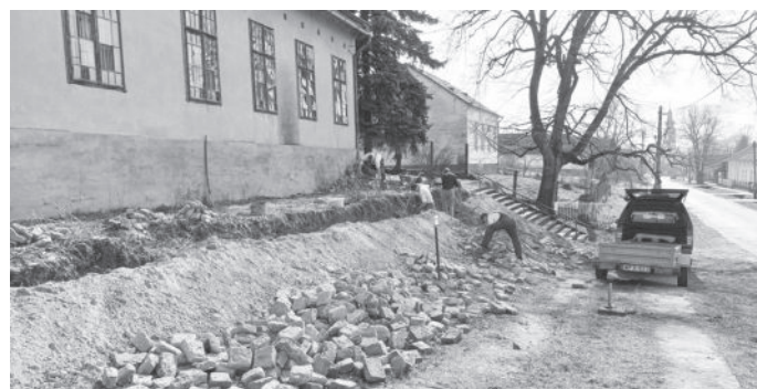
A kapolyi plébánia kerítésének bontása
